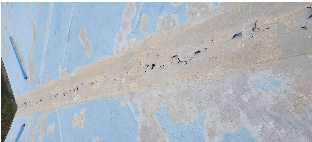
Fessurazioni diffuse in corrispondenza dei compluvi
